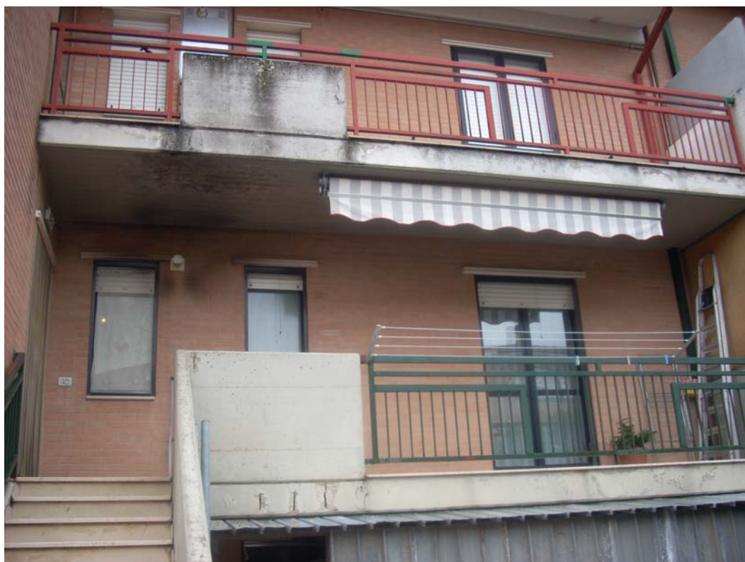
Foto 2 - SCALE ESTERNE (di accesso all'immobile al primo piano) E BALCONE
