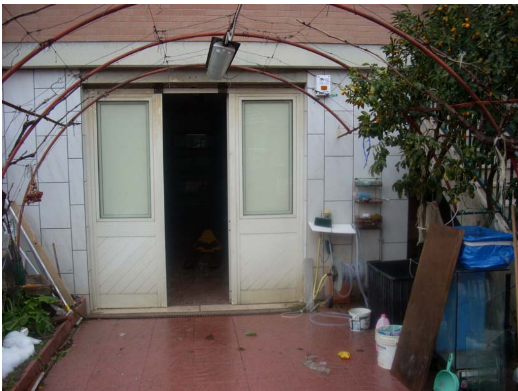
Foto 9 – PORTA DI ACCESSO ALL'AUTORIMESSA
