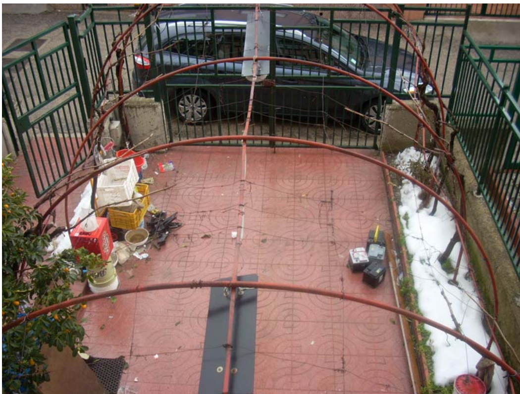
Foto 8 – RAMPA DI ACCESSO ALL'AUTORIMESSA
